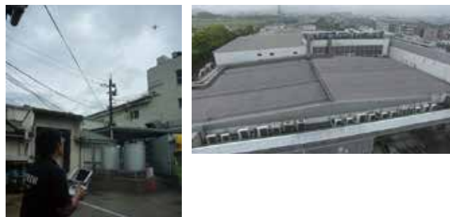
ドローンを活用した損害調査
